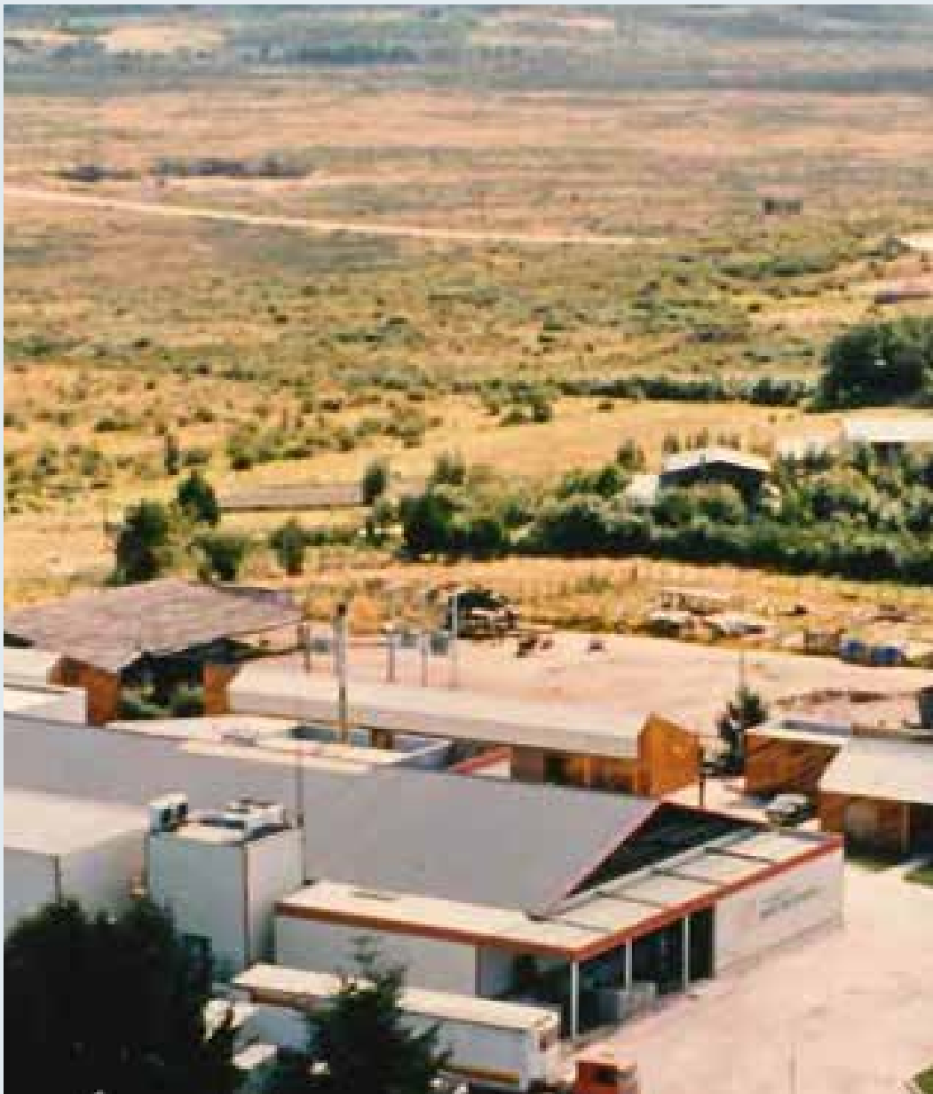
Inicios de la planta de procesos en Campus Cardonal.
